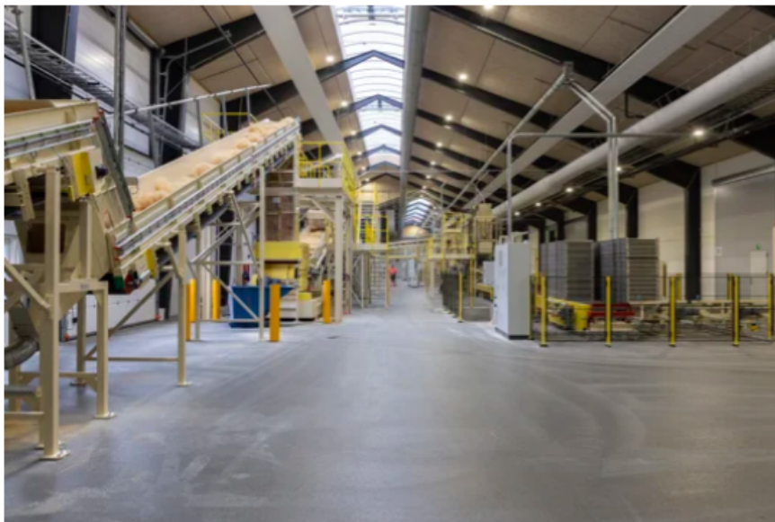
Figure 2 : Installation de production chez Troldekt Acoustic by Kingspan à Troldehede, Danemark
