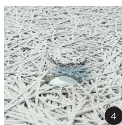
Placez les morceaux percés de laine de bois dans les trous avec le mastic
