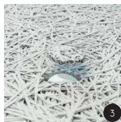
Découpez la laine de bois aux dimensions et utilisez-la pour combler le trou
