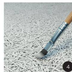
Utilisez la peinture de retouche de la même couleur que le panneau
