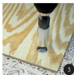
Utilisez la perceuse à bois pour égaliser le diamètre des trous
