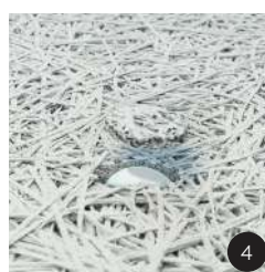
Placez les morceaux percés de laine de bois dans les trous avec le mastic
