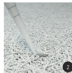
Appliquez le mastic
