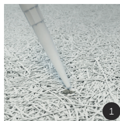
Appliquez le mastic
